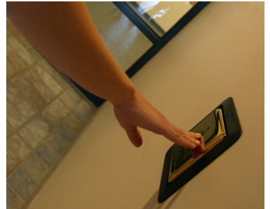
墙面安装实例
