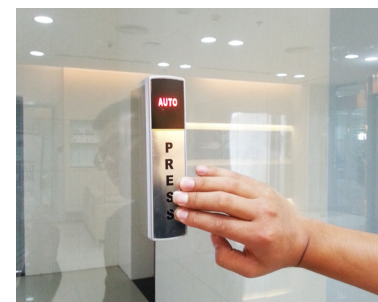
门扇安装实例
